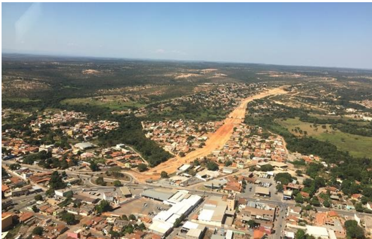
FIGURA 174: OBRAS DA AV. SUZANA PINTO CANABRAVA APÓS A LMG-754, NA CIDADE DE CURVELO. FONTE: HTTP://WWW.CURVELOMG.COM.BR/
