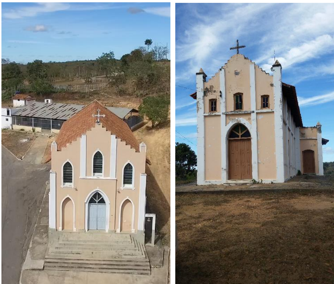
FIGURA 107: IGREJAS SITUADAS EM SANTA RITA DO CEDRO COM POTENCIAL PARA PRESERVAÇÃO. FONTE: MYR PROJETOS, 2016.
