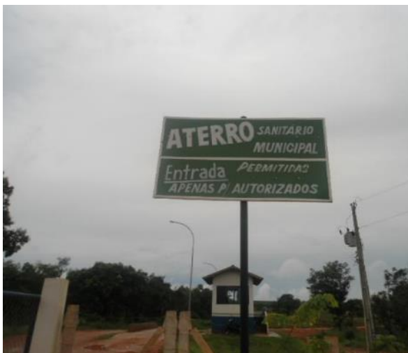
FIGURA 130: VISTA PARCIAL DA ENTRADA DO ATERRO MUNICIPAL. FONTE: PMS,2015.
