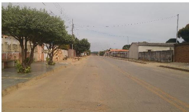
FIGURA 127: VIA PAVIMENTADA E SISTEMA DE DRENAGEM OBSERVADO NA PORÇÃO CENTRAL DO DISTRITO DE JK. FONTE: MYR PROJETOS, 2016.
