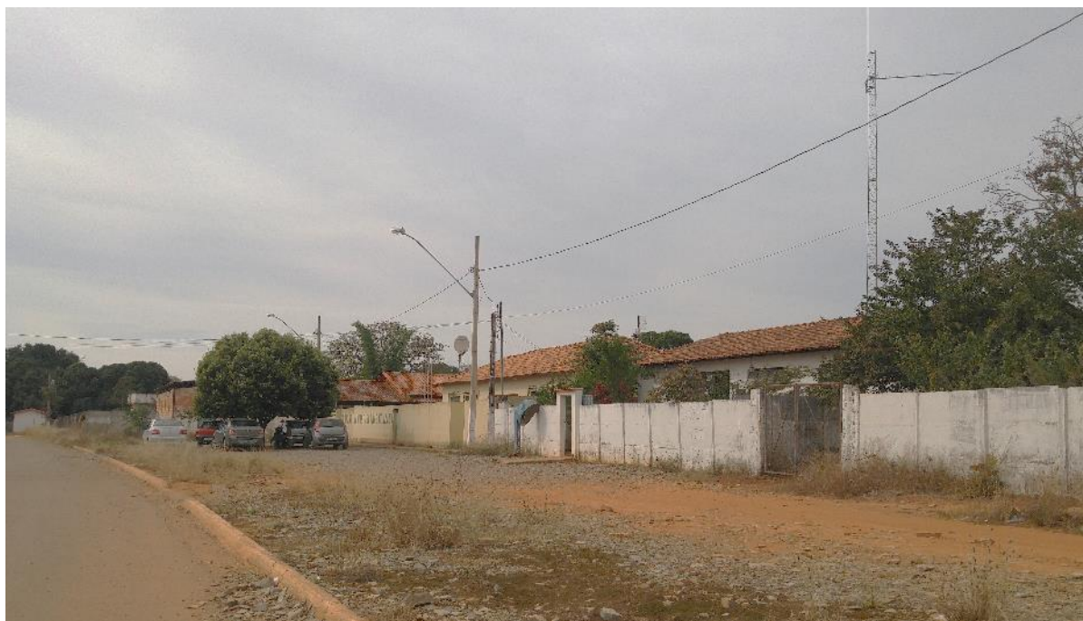
FIGURA 89: VIA DE ACESSO A ANGUERETÁ ONDE NÃO SE VERIFICOU INFRAESTRUTURA DE DRENAGEM E ESGOTAMENTO. FONTE: MYR PROJETOS, 2016.
