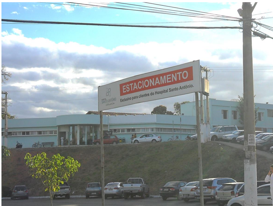
FIGURA 141: HOSPITAL SANTO ANTÔNIO LOCALIZADO NO BAIRRO SANTA MARIA. FONTE: MYR PROJETOS, 2016.
