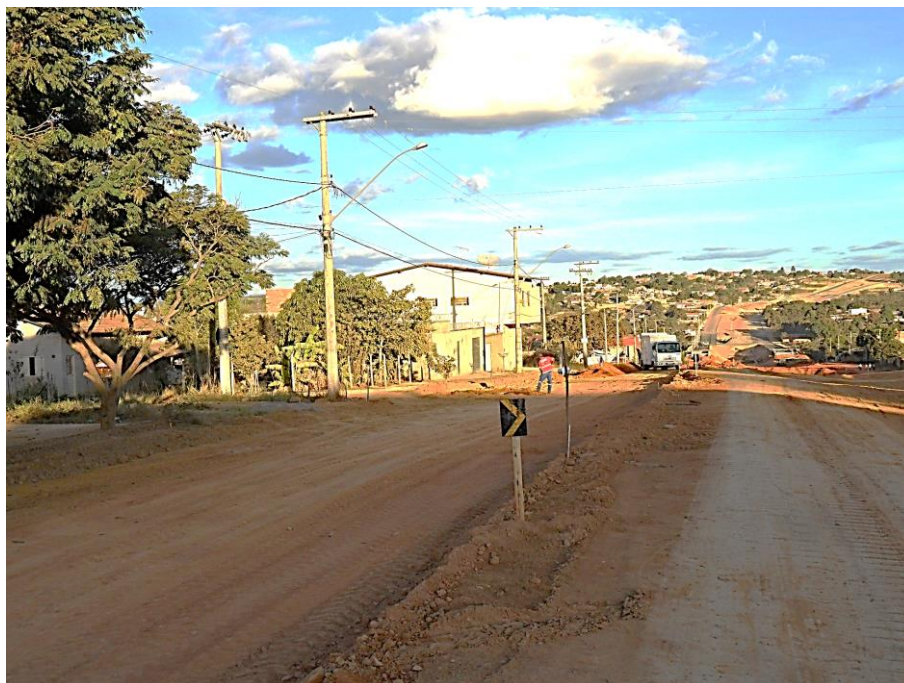
FIGURA 135 - LINHA TRANSMISSÃO OBSERVADA NA PORÇÃO SUL DA SEDE ONDE ESTÁ SENDO IMPLANTADA A AV. SUZANA PINTO CANABRAVA. FONTE: MYR PROJETOS, 2016.
