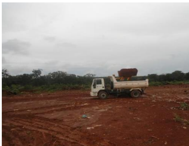
FIGURA 133: OPERAÇÃO DO ATERRO SANITÁRIO DE CURVELO. FONTE: PMS,2015.
