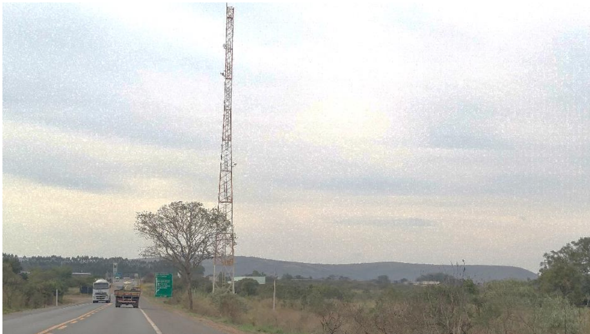
FIGURA 137: ANTENA PARA TELEFONIA VERIFICADA AS MARGENS DA BR 040, PRÓXIMO AO DISTRITO DE ANGUERETÁ. FONTE: MYR PROJETOS, 2016.
