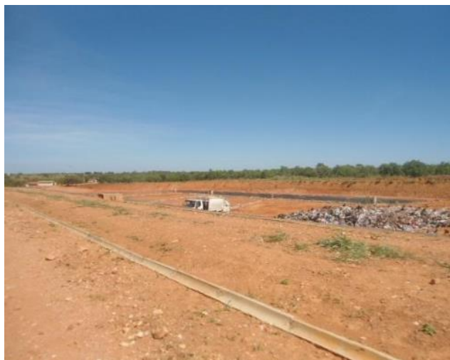
FIGURA 131: ÁREA DO ATERRO MUNICIPAL, COM CANALETAS DE DRENO. FONTE: PMS,2015.
