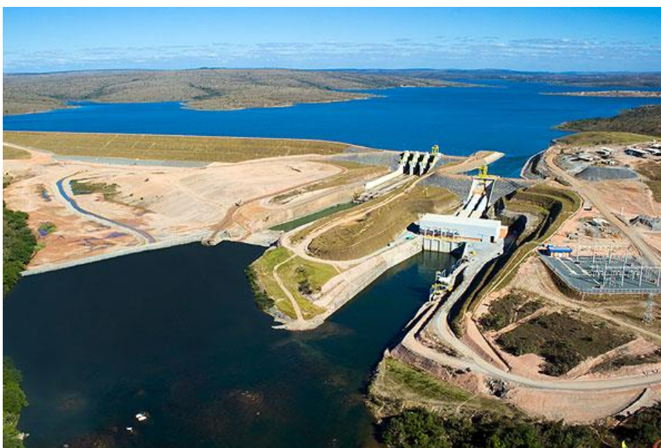
FIGURA 66: USINA HIDRELÉTRICA RETIRO BAIXO ENTRE CURVELO E POMPÉU. FONTE: FURNAS.
