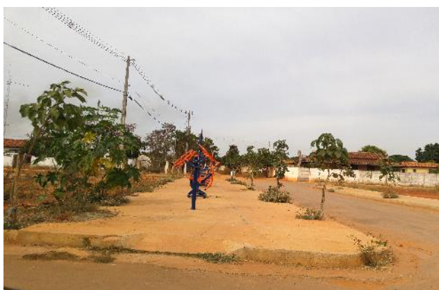
FIGURA 126: VIAS SEM SISTEMA DE DRENAGEM OBSERVADA PRÓXIMA A PRAÇA CENTRAL DO DISTRITO DE ANGUERETÁ. FONTE: MYR PROJETOS, 2016.
