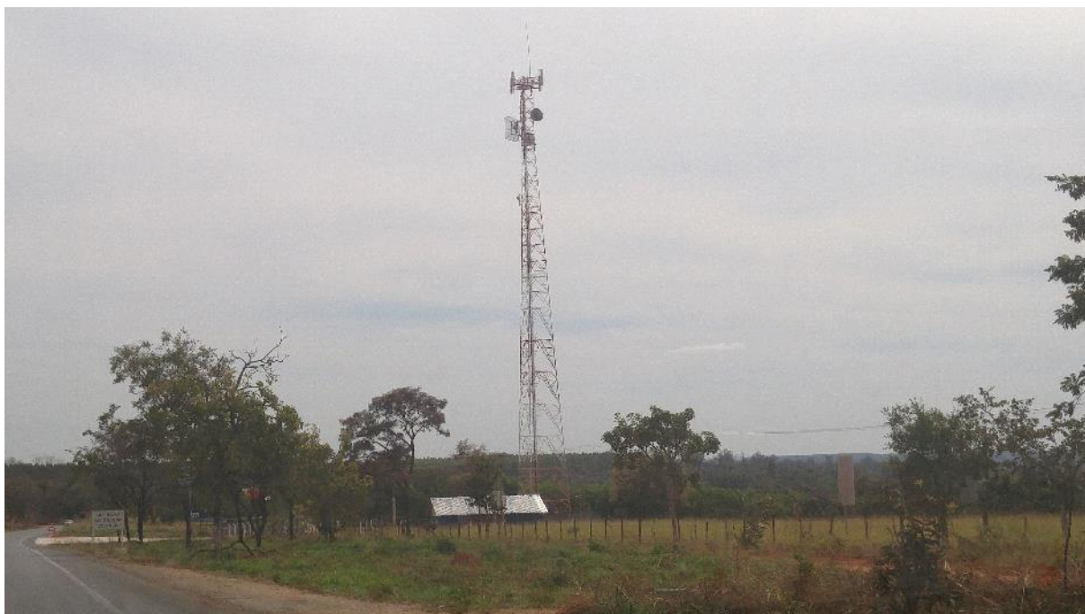
FIGURA 138: ANTENA PARA TELEFONIA VERIFICADA AS MARGENS DA BR 135, PRÓXIMO AO DISTRITO DE JK. FONTE: MYR PROJETOS, 2016.
