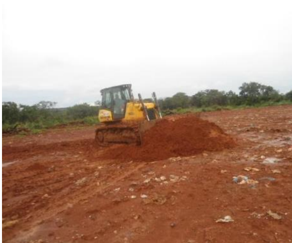
FIGURA 132: COMPACTAÇÃO DO LIXO SENDO REALIZADA NO ATERRO SANITÁRIO DE CURVELO. FONTE: PMS,2015.
