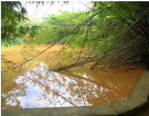
FIGURA 43: BARRAMENTO ARTIFICIAL VERIFICADO NO RIBEIRÃO SANTO ANTÔNIO A JUSANTE DO SETOR DE CAPTAÇÃO DE ÁGUA DA COPASA. FONTE: MYR PROJETOS, 2016.
