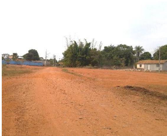
FIGURA 87: VIA SEM PAVIMENTAÇÃO E SEM MEIO FIO OBSERVADO EM ANGUERETÁ. MYR PROJETOS, 2016.
