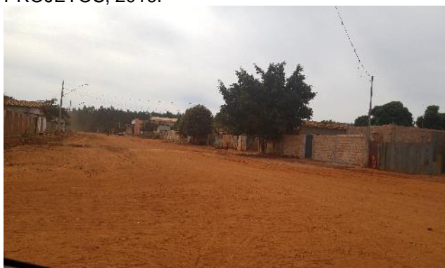
FIGURA 128: VIA SEM PAVIMENTAÇÃO E SEM SISTEMA DE DRENAGEM OBSERVADA NA PORÇÃO SUL DO DISTRITO DE JK. FONTE: MYR PROJETOS, 2016.
