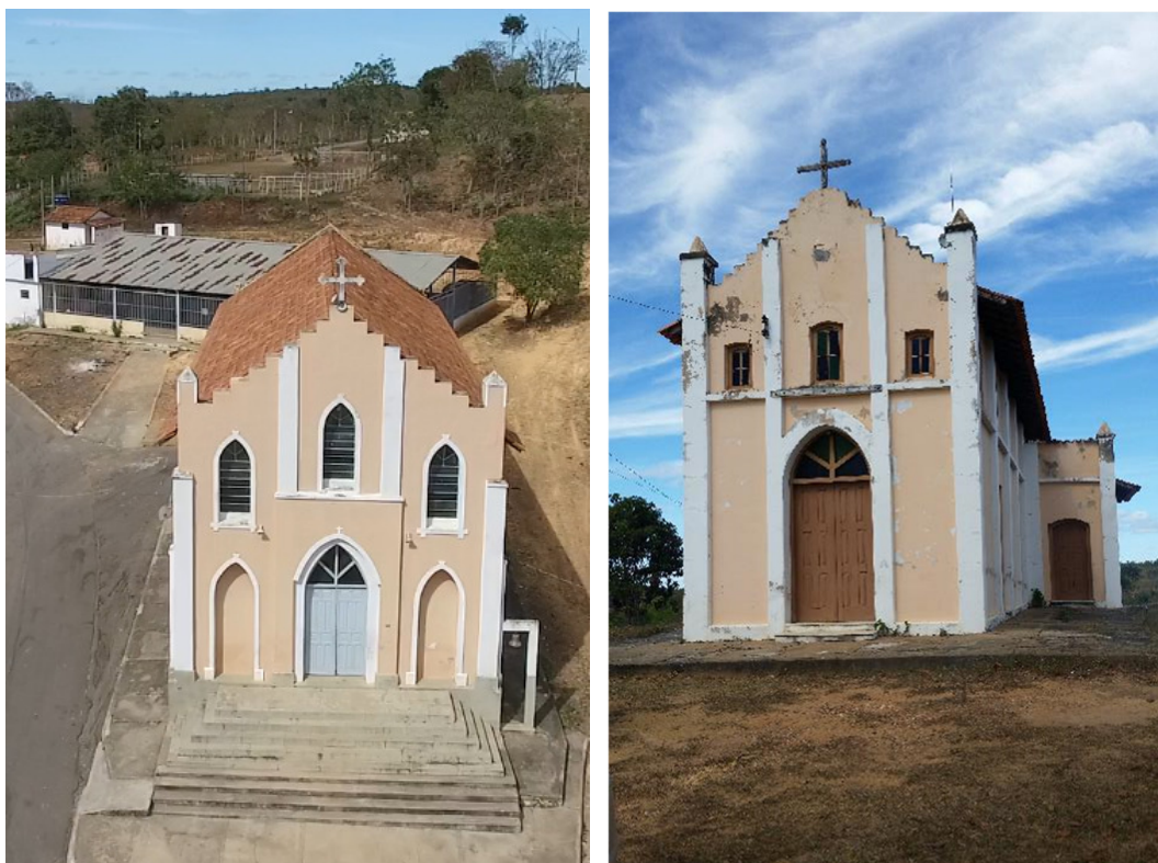
FIGURA 12. IGREJAS SITUADAS EM SANTA RITA DO CEDRO COM POTENCIAL PARA PRESERVAÇÃO.
