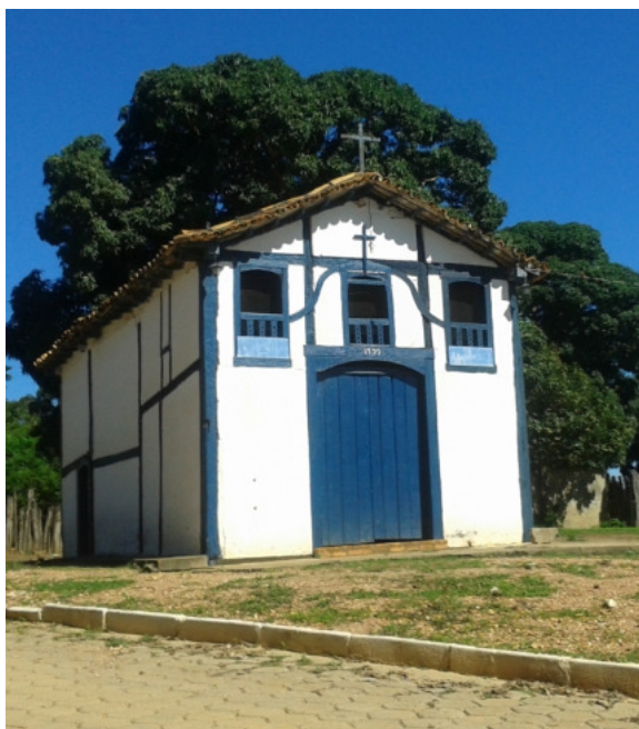
FIGURA 9. CAPELA N. S. DO LIVRAMENTO
